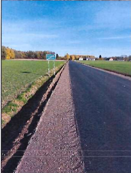
DP3204W Czernice Borowe - Chrostowo Zalesie, przebudowany odcinek w m. Chrostowo Zalesie
