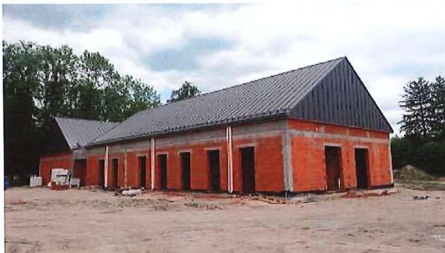
Środowiskowy Dom Samopomocy w Przasnyszu ul. Ruda w trakcie budowy
