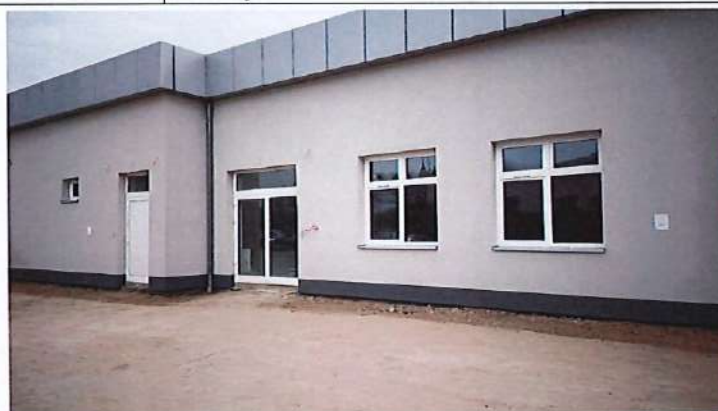
Wejście główne do budynku ZOL
