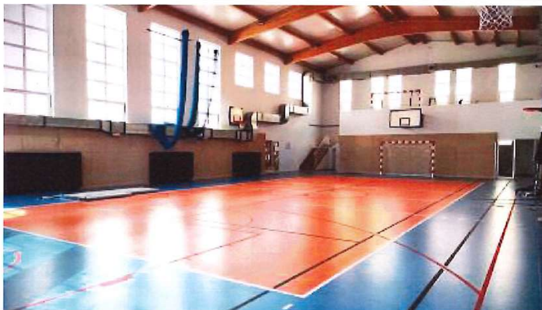
Wyremontowana sala gimnastyczny w Liceum Ogólnokształcącym im. KEN w Przasnyszu.
